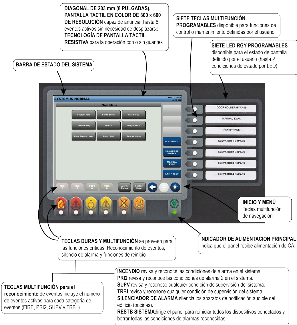
Figura 4: Interfaz de operador de pantalla táctil ES
